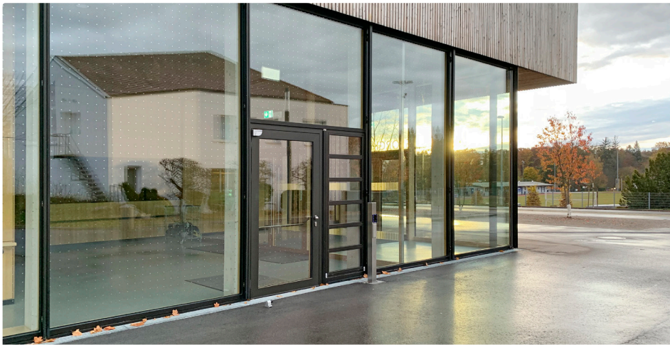
Um Vogelkollisionen mit Glas zu vermeiden, wurden die grossen Scheiben der Sporthalle Waldau in Stuttgart mit einer Vogelschutzmarkierung versehen (© Rouven Seidler).
