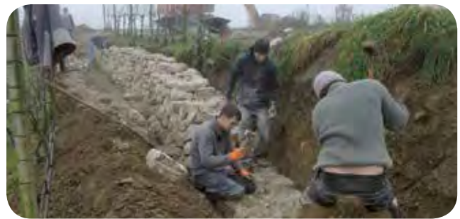
Der Bau neuer Trockenmauern trägt zur Erhaltung ländlicher Baukultur bei und schafft einen Lebensraum für Lebewesen mit unterschiedlichsten Ansprüchen.
