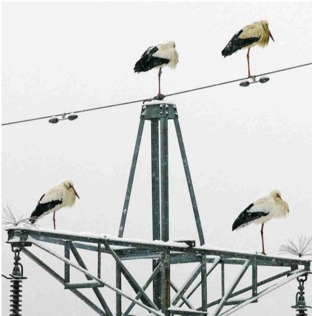
Abb. 6. Die Masten der Stromleitungen sollten so gebaut sein, dass auch grosse Vögel keinen Kurzschluss verursachen können (J.-L. Zimmermann)
