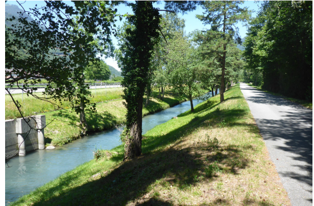
Fig. 29. Le canal de la Salanfe bordant la digue externe mériterait un entretien plus extensif, voire des plantations permettant de former des zones buissonnantes.
