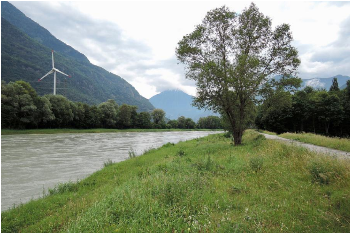
Fig. 12. Exemple gestion de digue contraire aux directives. Les zones de buissons sont totalement absentes en bordure de zone A comme dans tout l'espace de la zone B.
