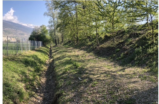
Fig. 29. L'entretien des canaux latéraux ou des meunières devrait se faire de façon extensive pour maximiser les connections avec le Rhône.
