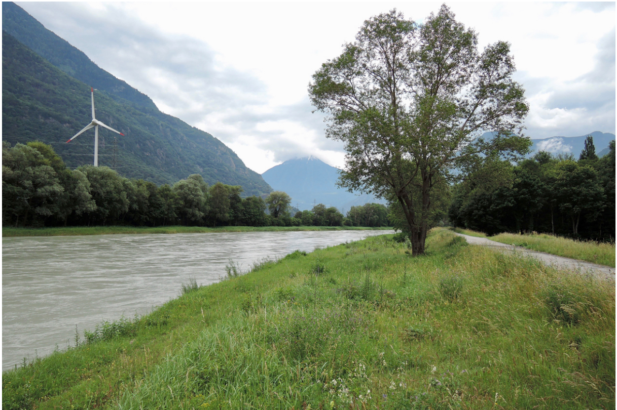
Fig. 12. Exemple gestion de digue contraire aux directives. Les zones de buissons sont totalement absentes en bordure de zone A comme dans tout l'espace de la zone B.
