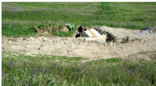
Figure 6 | Construction de nouvelles installations d'irrigation à proximité de précieuses prairies à sauge, à avoine jaunâtre et à fromental à Sent, en 2010. (Photo: Roman Graf)
