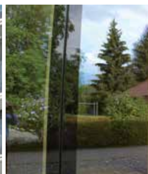
Façade fortement réfléchissante
