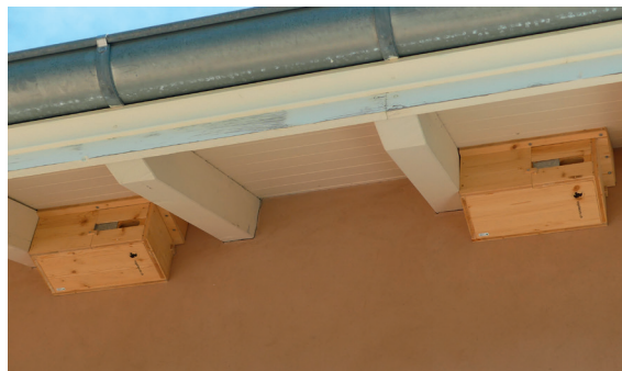
Bild 2: Typischer Mauersegler-Nistkasten mit Schliessvorrichtung. Das Einflugloch kann auf der langen (siehe Foto) oder alternativ auch auf der kurzen Seite angebracht werden (Foto: Hans Schmid).
