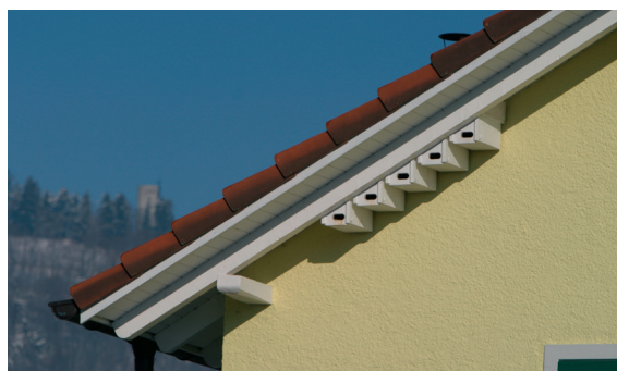
Bild 4: Auch an der Dachschräge lassen sich Seglernistkästen installieren (Foto: Alain Georgy).
