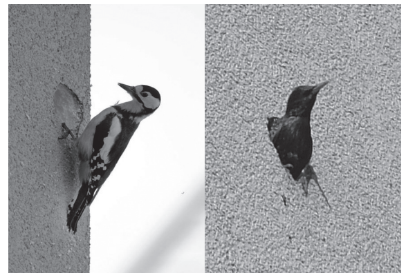
Abb. 1: Buntspecht mit Loch an aussenisolierter Fassade (Foto: R. Oeschger).
