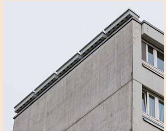
Sugli edifici del personale dell'ospedale di Frauenfeld sono stati creati siti di nidificazione alternativi (foto: Sandra Schweizer).
