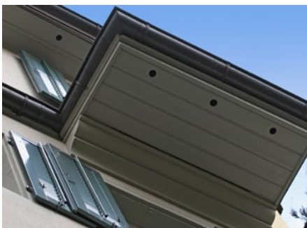
Auch unter Vordächern und Balkonen lassen sich unauffällige Brutstellen einbauen. Das ist selbst an historischen Bauten möglich.
