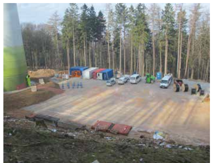
Bei Windenergieanlagen im Wald geht der Flächenbedarf weit über den Fundamentgrundriss des Turms hinaus, denn zur Anlage gehören auch Flächen für den Montagekran, das Materiallager und für die Zufahrtsstrasse. Das Bild stammt aus dem Bundesland Rheinland-Pfalz und wurde während der Bauarbeiten des Hunsrück-Windparks Ellern gemacht (Foto: Demian Bölsterli).
