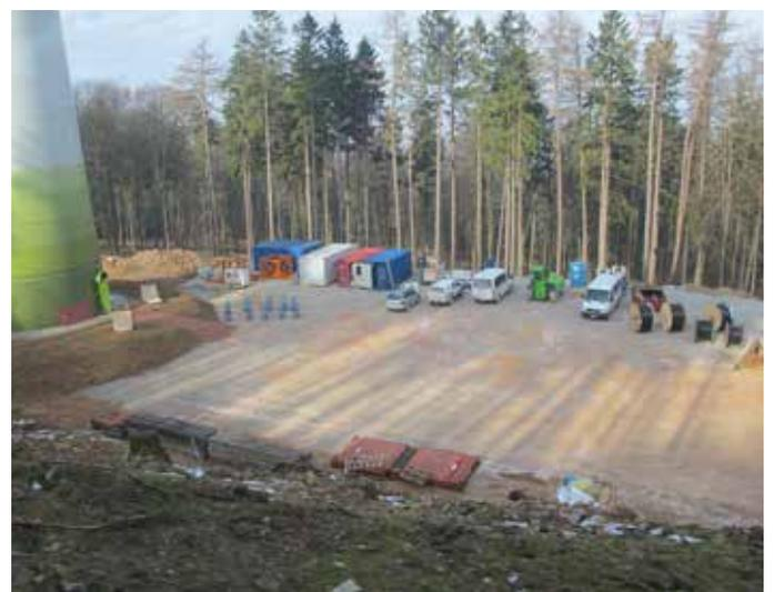
La construction d'une éolienne en forêt exige une surface au sol bien plus grande que les seules fondations du mât : la grue de montage, le matériel et la route d'accès prennent aussi de la place. La photo a été prise pendant le chantier du parc éolien d'Hunrück à Ellern, en Rhénanie-Palatinat (photo : Demian Bölsterli).
