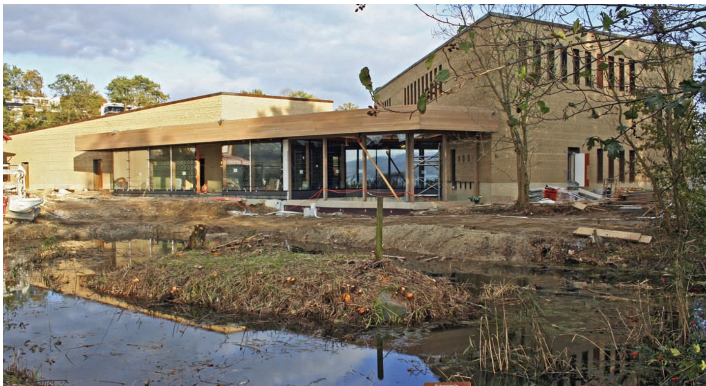
Das neue Besuchszentrum der Vogelwarte ist das erste dreistöckige Lehmgebäude der Schweiz. Die Erstellung ist eine bauökologische Pionierleistung (Foto: Schweizerische Vogelwarte).
