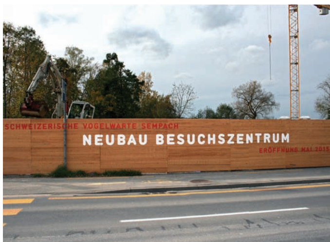
Hinter dieser Bauabschrankung entstand in knapp zweijähriger Bauzeit das neue Besuchszentrum der Vogelwarte (Foto: Schweizerische Vogelwarte).
