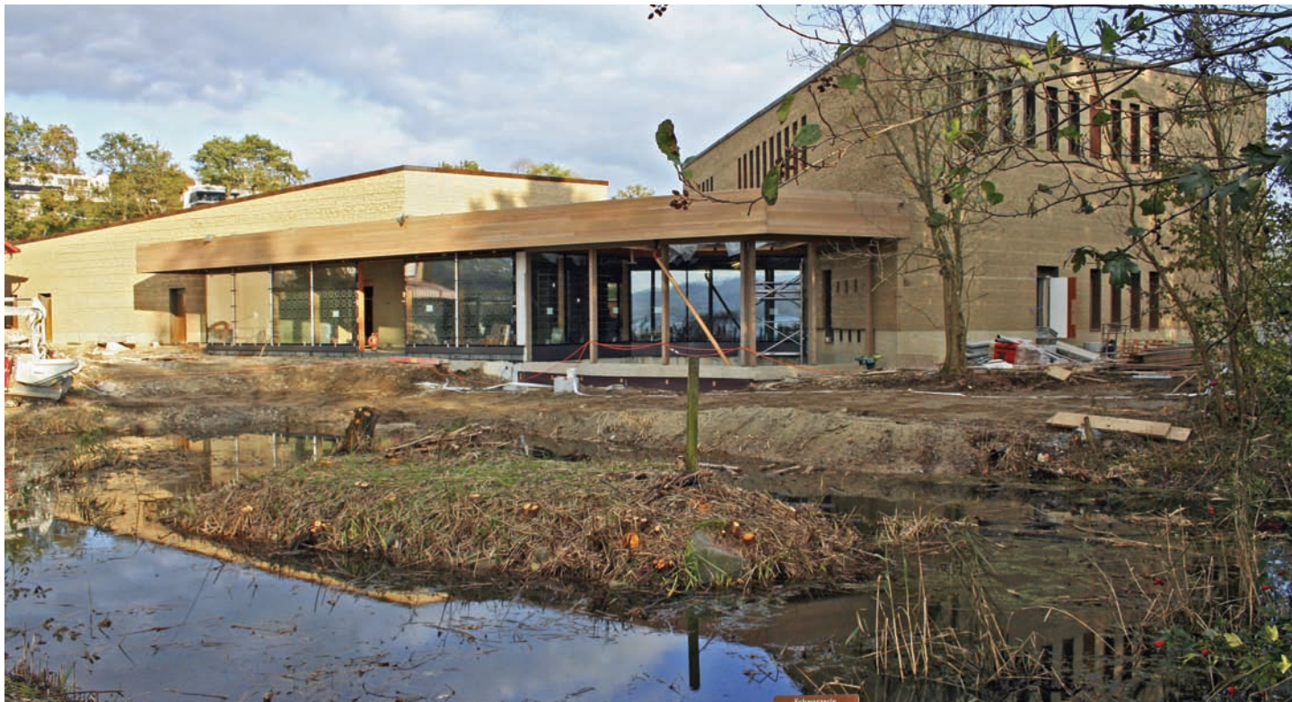
Le nouveau centre de visite de la Station ornithologique est le premier bâtiment à trois étages en terre crue de Suisse. Sa réalisation est une performance pionnière en matière de construction écologique (photo: Station ornithologique suisse).
