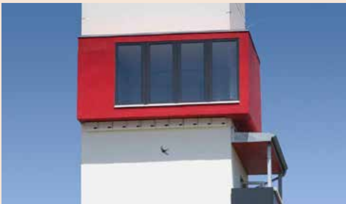
Originelle Idee: Mauerseglernistkästen am Schlauch- und Übungsturm der Feuerwehr der Stadt Offenbach am Main (Foto: Stadt Offenbach a. Main).
