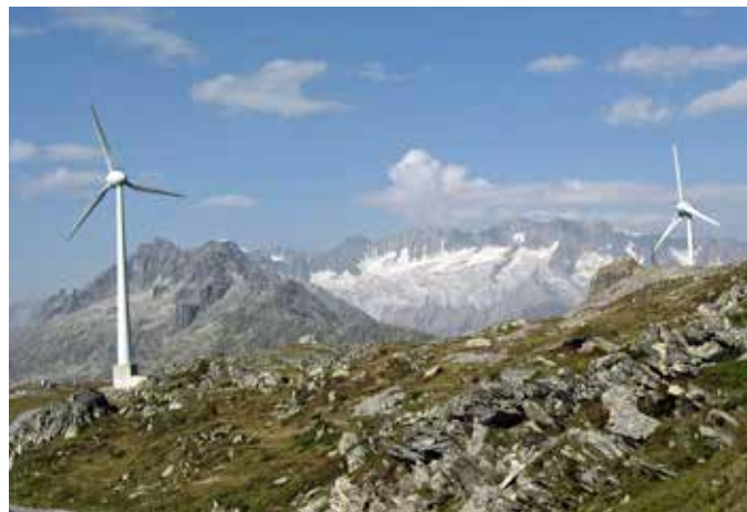
Le parc éolien Gütsch sur les hauts d'Andermatt, UR (photo: Daniela Heynen).
