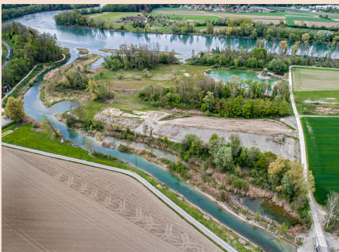
Luftaufnahme der revitalisierten Aue Chly Rhy in Riethem AG. Die im Zentrum gut sichtbare, knapp hektargrosse und vom Flussregenpfeifer besiedelte Ruderalfläche wird von einem Weg und zwei Gehölzreihen begrenzt (Foto: Oekovision GmbH, 8967 Widen).
