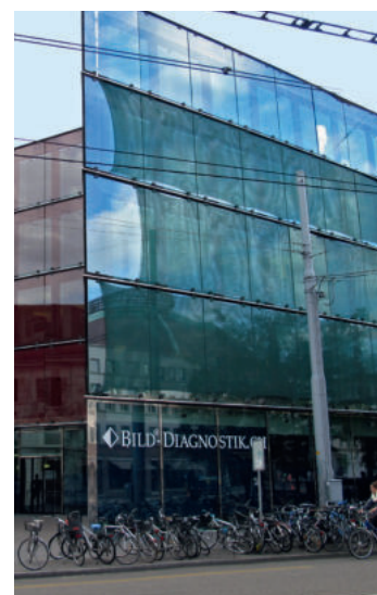
An stark spiegelnden Fassaden können in Zeiten der akuten Gefährdung von Zugvögeln auch temporäre Massnahmen ergriffen werden. Am Elsässer Tor in Basel wurde vorbildlich gehandelt: Dieses Jahr schützten feinmaschige Netze vor Anflügen (Foto: Marc Kéry).
