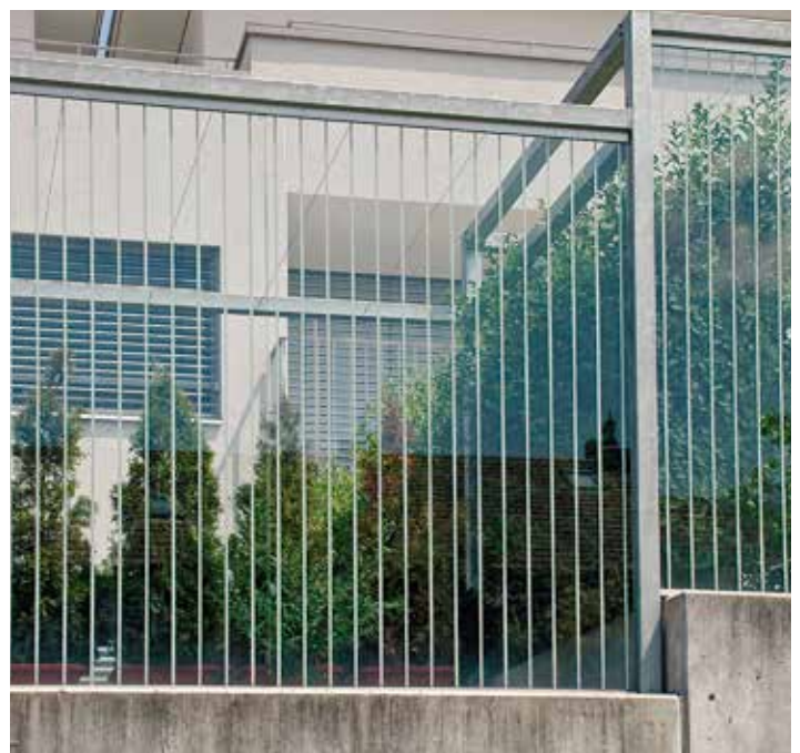
Streifen auf Lärmschutzwänden können durchaus diskret sein. Wegen der Hecke hinter der Glasfront sind die Markierungen hier aber besonders wichtig (Foto: Daniela Heynen).
