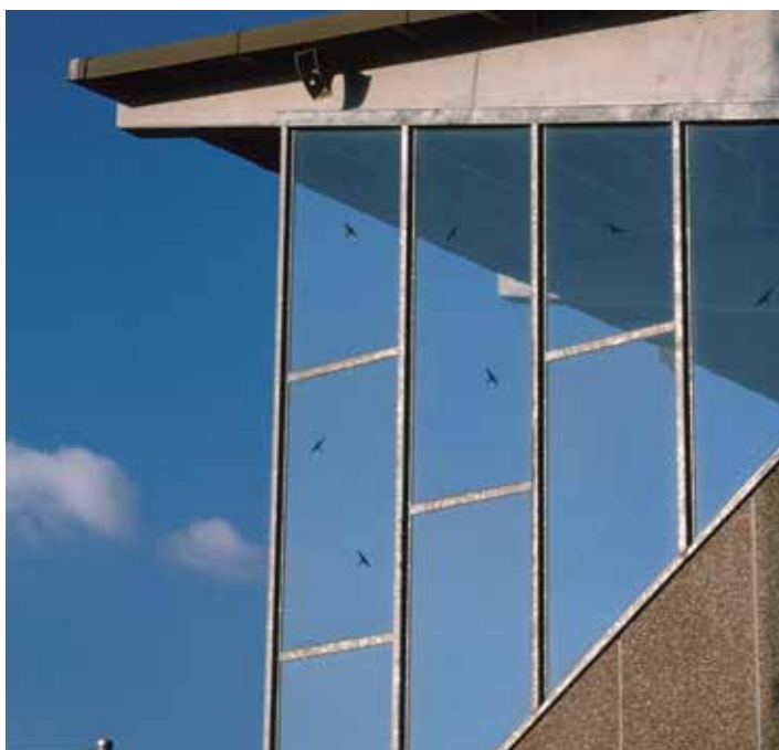
Eine solche Windschutzverglasung bildet für Vögel ein unsichtbares Hindernis. Die Greifvogelsilhouetten sind viel zu weit voneinander entfernt, um die Kollisionen massiv zu reduzieren (Foto: Hans Schmid).
