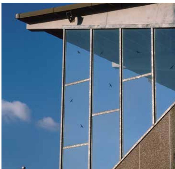
Ce vitrage de protection contre le vent n'est pas un obstacle visible pour les oiseaux. Les silhouettes de rapaces sont bien trop espacées pour minimiser les collisions (photo: Hans Schmid).
