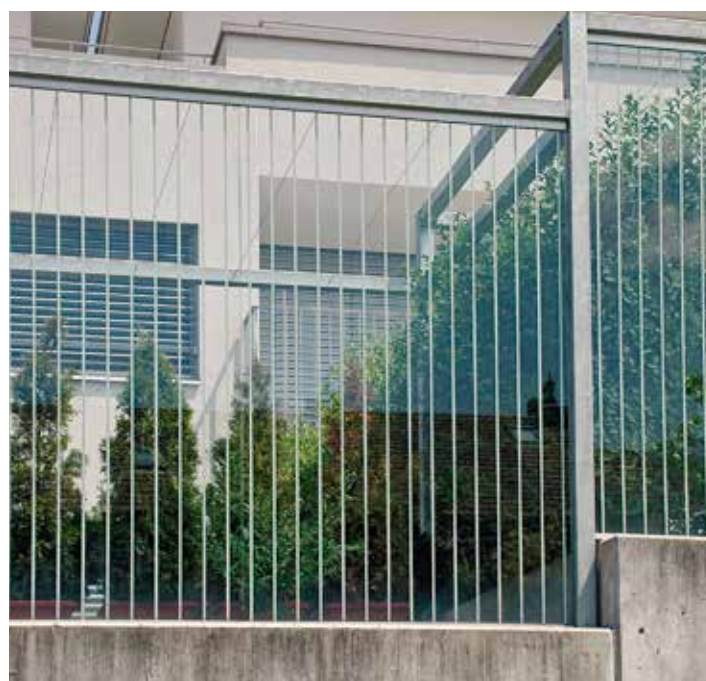
Les parois antibruit peuvent être munies de bandes discrètes. Le marquage est ici particulièrement important car la haie se trouve derrière le verre (photo: Daniela Heynen).
