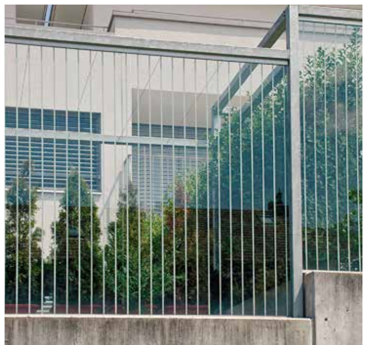
Le pareti fonoisolanti possono essere munite di strisce discrete. Qui la marcatura è particolarmente importante poiché dietro al vetro c'è una siepe (foto: Daniela Heynen).
