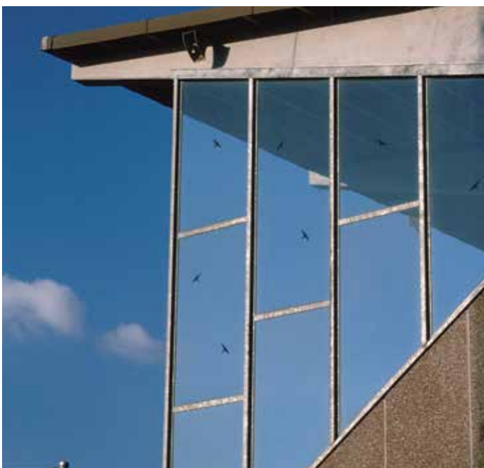
Per gli uccelli questa vetrata frangivento non rappresenta un ostacolo visibile. Le sagome di rapaci sono troppo distanziate per ridurre al minimo le collisioni (foto: Hans Schmid).
