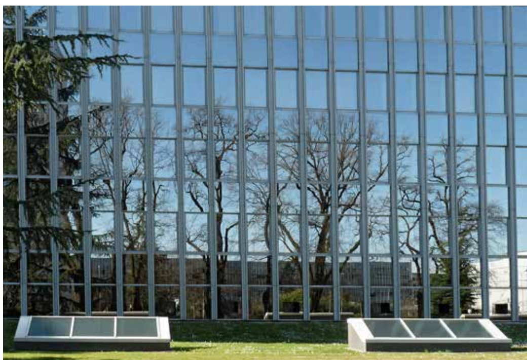
Questa facciata in vetro a Ginevra riflette fedelmente gli alberi dei dintorni: ciò causa un forte rischio di collisione per gli uccelli (foto: Bastien Guibert).
