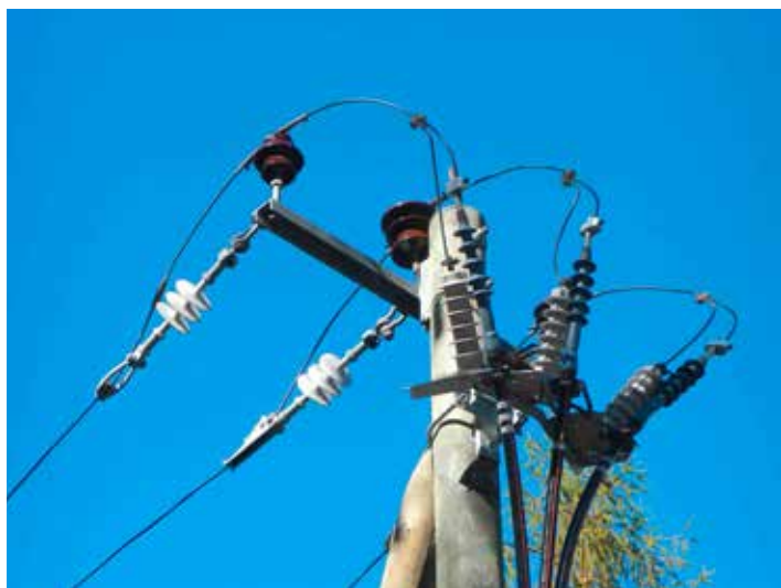
Su questo pilone di una linea a media tensione i conduttori non sono isolati. A partire da una certa dimensione, un uccello può toccare contemporaneamente due elementi sotto tensione e subire così un'elettrocuzione letale (Foto: D. Berthold).
