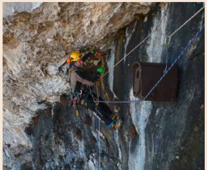
Ein luftiger Arbeitsplatz! Hier war sogar die Feuerwehrleiter zu kurz: in der Deponie Unterkobel Oberriet kamen Höhenarbeiter zu einem nicht ganz alltäglichen Einsatz. Jetzt brüten dort Dohlen als Nachbarn zu Wanderfalke und Uhu (Foto: Roland Thür & Dominik Suntinger).
