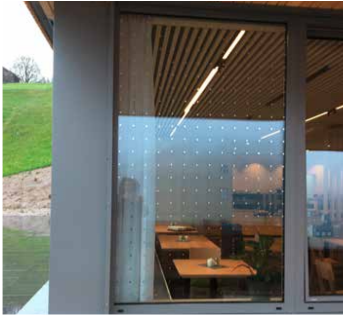
Mit «Seen Elements» versehene Glasscheiben. Mit seinen hochreflektierenden Aluminiumelementen schnitt das Produkt bei Tests der biologischen Station Hohenau in Österreich gut ab (Foto: OBAD Stempel GmbH & Co.KG).
