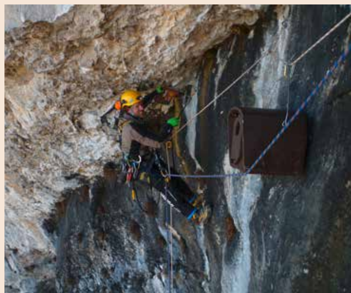
Un posto di lavoro ben arieggiato! Qui era troppo corta persino la scala dei vigili del fuoco: nella discarica Unterkobel a Oberriet, i tree climber sono stati incaricati di una missione non del tutto usuale. Ora lassù le taccole nidificano accanto al Falco pellegrino e al Gufo reale (foto: Roland Thür & Dominik Suntinger).
