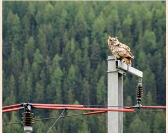
Le grand-duc d'Europe s'installe volontiers sur les pylônes des lignes aériennes des trains. En Engadine, 250 mâts des RhB ont désormais été isolés pour éviter les électrocutions (photo : David Jenny et Werner Fischer).
