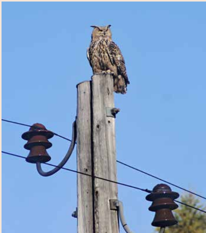
Les mâts de lignes à moyenne tension sont plus ou moins dangereux selon leur conception. Il ne faut pas qu'un grand-duc perché touche de ses ailes ouvertes deux éléments avec une différence de potentiel. Les pylônes en bois sont parmi les moins dangereux (photo : David Jenny et Werner Fischer).
