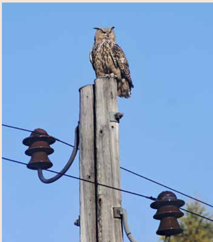
Esistono tipi pericolosi e meno pericolosi di piloni di media tensione. Determinante è se un gufo reale seduto con le ali aperte possa toccare elementi che conducono corrente, causando così un corto circuito o una connessione a terra. I piloni in legno sono tra i tipi meno pericolosi (foto: David Jenny e Werner Fischer).
