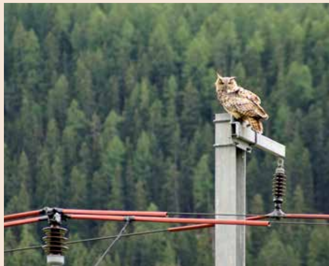
I tralicci di catenaria della ferrovia vengono utilizzati volentieri dai gufi reali quali posatoi. In Engadina, 250 tralicci della Ferrovia retica sono stati nel frattempo risanati con un'isolazione contro l'elettrocuzione (foto: David Jenny e Werner Fischer).
