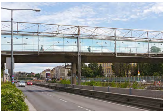
Les parois coupe-vent sur les ponts et passerelles vitrées sont parmi les pièges les plus fréquents pour les oiseaux. Nombre d'entre eux arborent des silhouettes de rapaces. Ces formes sont inefficaces, mais leur présence attestent que des collisions s'y produisent.
