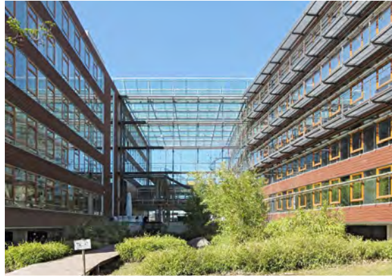
Les cours intérieures végétalisées, ou les zones entourées de bâtiments, augmentent le risque de collision contre les surfaces vitrées. Depuis le ciel, la végétation au milieu d'un océan d'habitations attire les oiseaux. En revanche, le décollage avec un angle élevé peut être difficile.
