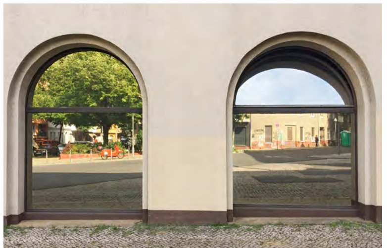
Les films de protection solaire réfléchissants produisent des images reflétées très fidèles : les oiseaux prennent ces fenêtres pour des passages ouverts.
