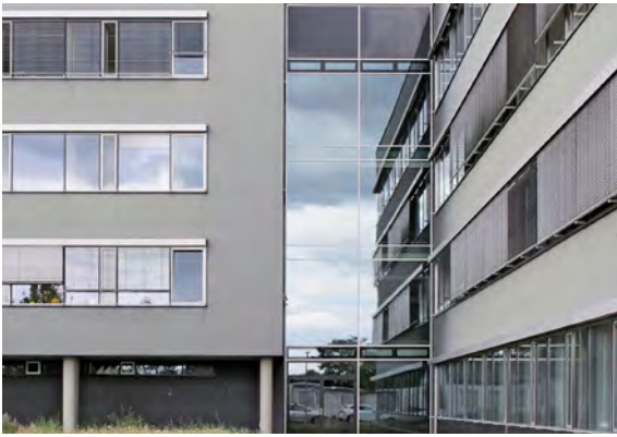
Les longues rangées de fenêtres et les surfaces réfléchissantes sont interprétées par les oiseaux comme une possibilité béante de traverser la structure du bâtiment. Les différentes frontières entre les surfaces vitrées n'ont ici aucun effet dissuasif.
