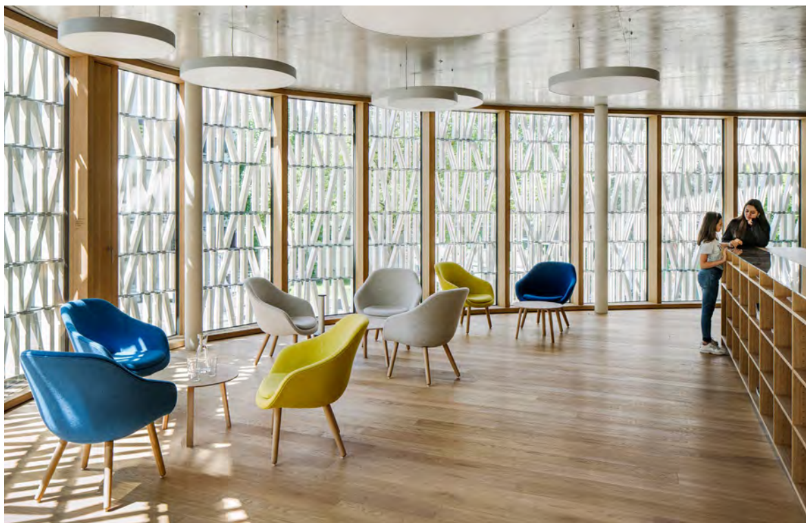
Le pavillon ovale vitré de la bibliothèque municipale de Dornbirn (Autriche), ouvrage de Dietrich | Untertrifaller, est enveloppé d'une structure formée de 8000 éléments de céramique préfabriqués. Disposés à la verticale et en diagonale, ces ornements protégeant du soleil évoquent des étagères de livres. Ils dispensent une lumière agréable dans les locaux.
