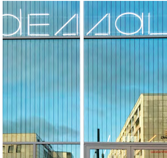
Pour lutter contre les collisions d'oiseaux, le nouveau Bauhaus Museum de Dessau (Allemagne) a couvert après coup plus de 2700m 2 de façade vitrée d'un motif ligné découpé.
