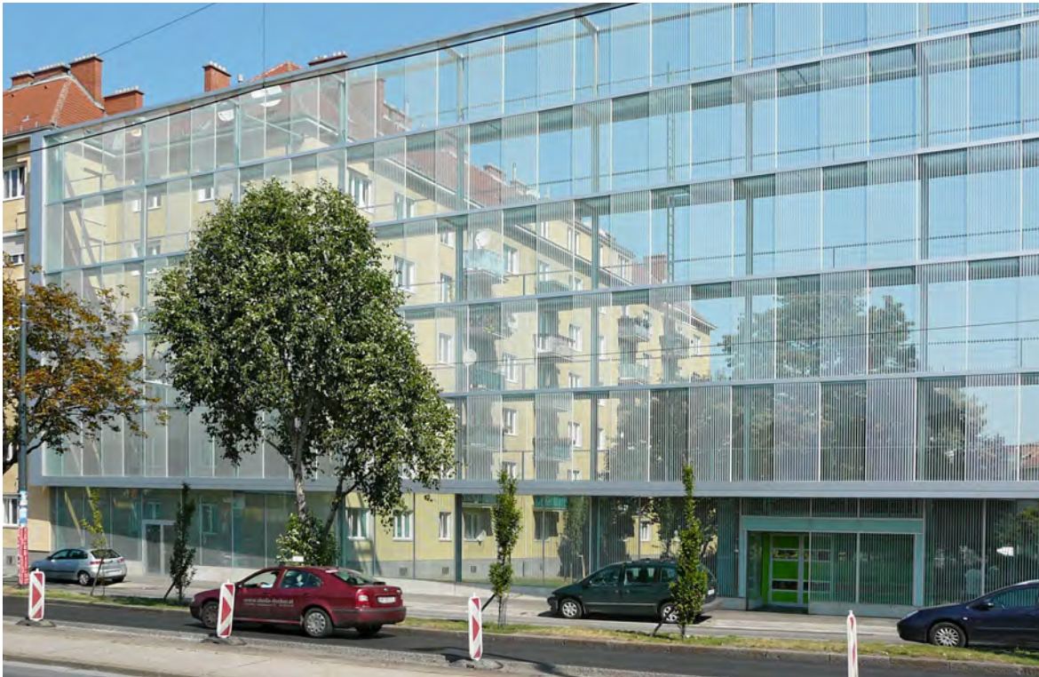
La structure en trois dimensions de la paroi anti-bruit conçue au Theodor-Körner-Hof à Vienne par Treusch architecture est volontairement mise en évidence par la trame appliquée pour protéger les oiseaux.
