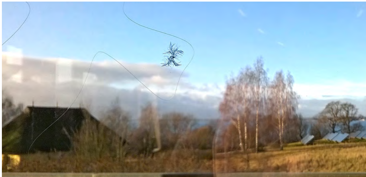
Les silhouettes transparentes réfléchissant les UV ne sont pas repérées par les oiseaux. On trouve parfois des traces de collision directement sur ce genre d'autocollants.
