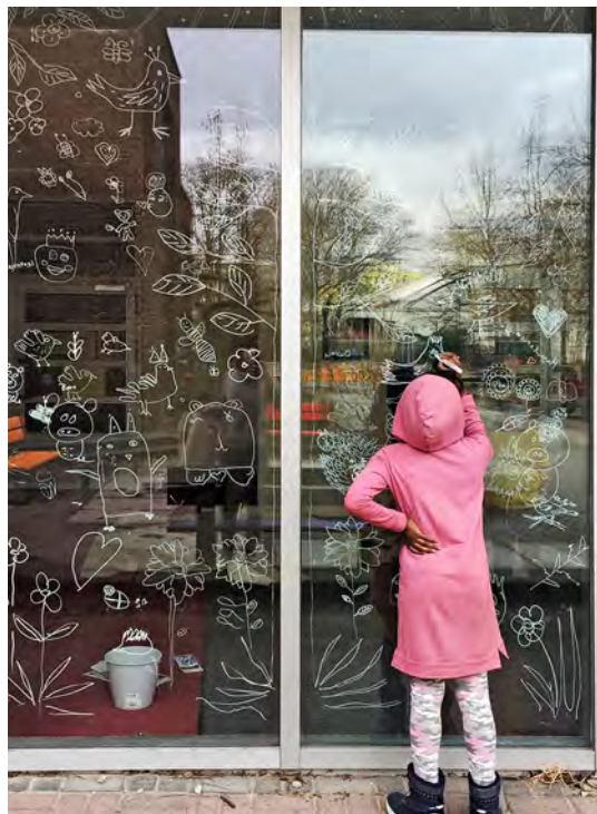
Les motifs de ce marquage créatif seront répartis sur toute la surface et ne laisseront pas de grandes lacunes. Ils gênent peu la vue vers l'extérieur, et n'empêchent pas la lumière d'entrer.
