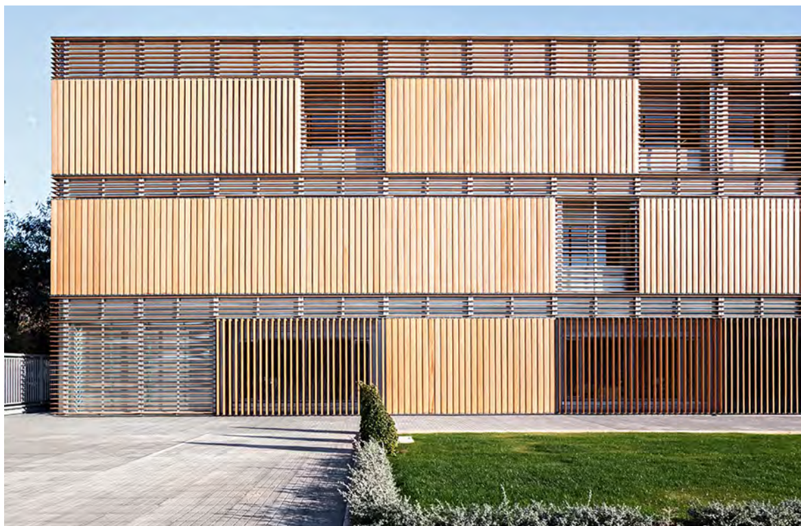
Nel blocco ovest del Centre d'Idiomes de la Universitat de València dello studio di architettura Arkitera SLP la struttura della facciata è determinata dalla combinazione di lamelle fisse e mobili per la protezione solare.
