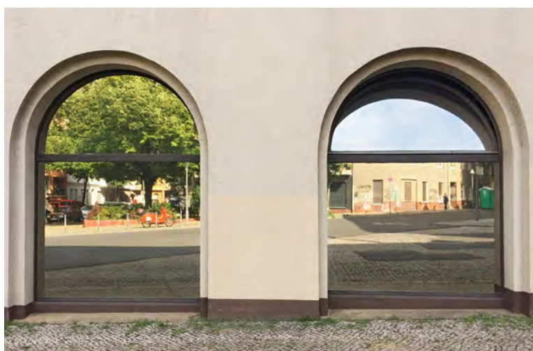
Pellicole per la protezione solare riflettenti creano immagini speculari realistiche: gli uccelli percepiscono queste finestre come un passaggio attraversabile in volo.
