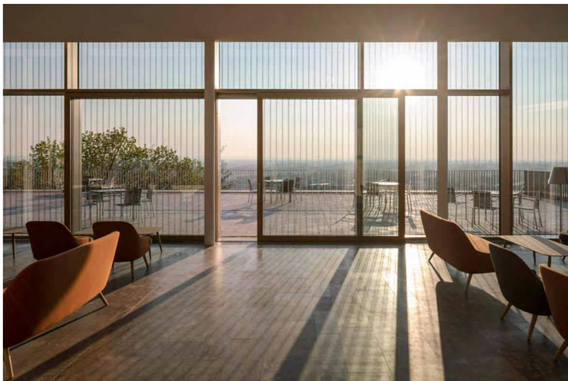
Durante la ristrutturazione dell'Abbazia di Michaelsberg, lo studio caspar.architects ha inserito come elemento di design marcature altamente efficaci per proteggere gli uccelli dalle collisioni.
