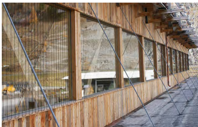
Dopo ripetute collisioni di uccelli contro le finestre riflettenti di un capannone a S-chanf (Svizzera), davanti ad esse sono state tese corde di nylon nero a una distanza di 8-10 cm. Dopo l'intervento non sono più state documentate collisioni di uccelli.
