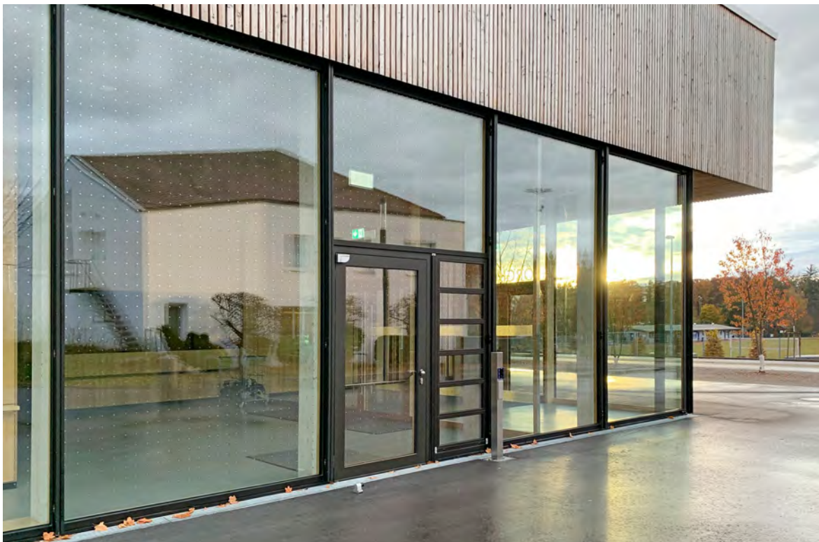
Questo reticolo di punti metallici larghi 9 mm a una distanza di 90 mm è laminato all'interno di un vetro isolante e tuttavia altamente efficace. A causa dei riflessi, finora le marcature nere potevano avere successo solo sul lato esterno delle vetrate di una facciata.
