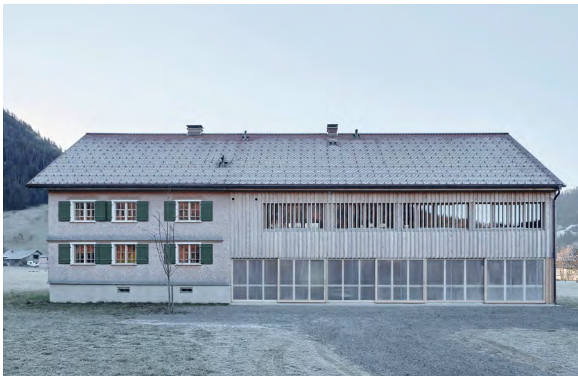
Nel corso di un cambiamento di destinazione, durante la ristrutturazione della casa Grossenbündt a Hittisau (Austria), tutelata come monumento storico, la gruber locher architekten ha riunito le superfici di accesso dietro uno strato semitrasparente. Per motivi di protezione solare, la struttura della facciata tradizionale in legno è stata fatta proseguire al piano superiore mediante una lunga fascia di finestre, mentre nell'ala residenziale sono state conservate le classiche finestre a cassetta. Gli uccelli sono in grado di riconoscere bene questi materiali e queste strutture.
