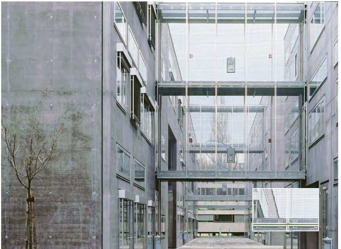
Le singole unità costruttive dell'Università Tecnica di Graz (Austria), dello studio di architettura Riegler Riewe, sono collegate da ponti a più piani. Gli elementi di facciata realizzati in griglia di acciaio offrono trasparenza e illuminazione, restando comunque facilmente riconoscibili come ostacolo da parte degli uccelli.
