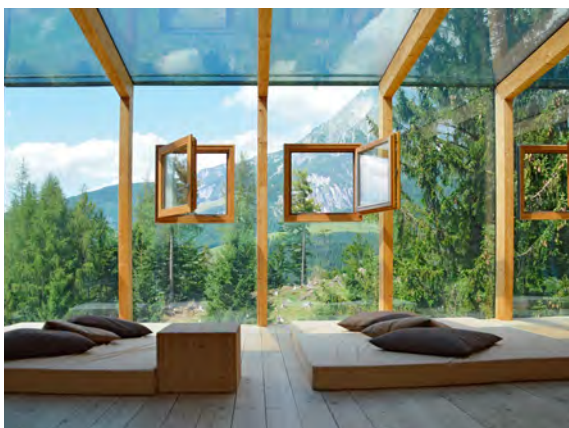
Concetti architettonici che costruiscono fluide transizioni tra interno ed esterno, promettendo una vita come in natura, creano barriere mortali per tutto ciò che vola.
