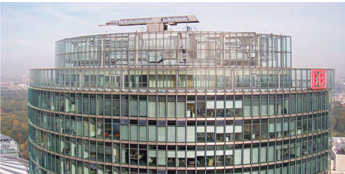
Attici vetrate alti diversi metri su un grattacielo: qui gli uccelli non si schiantano solo dall'esterno, ma vanno a sbattere contro le vetrate anche dall'interno quando finiscono nell'area recintata.
