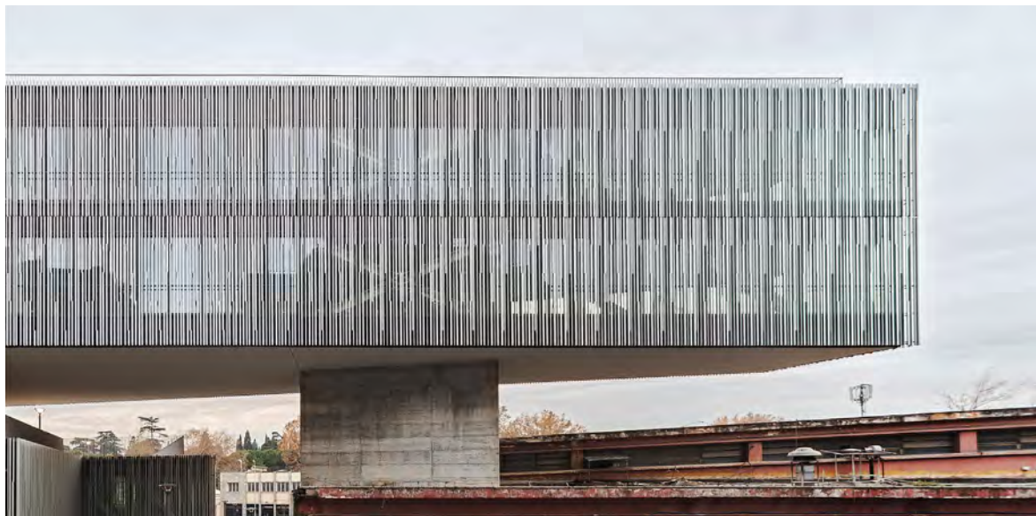
La Città del Sole a Roma dello studio di architettura Labics è un complesso multifunzionale con funzioni pubbliche e private. Sia il design della facciata realizzata con profili in alluminio che le lamelle in vetro traslucido sui vari edifici garantiscono sia la protezione dal sole, sia la protezione degli uccelli.
