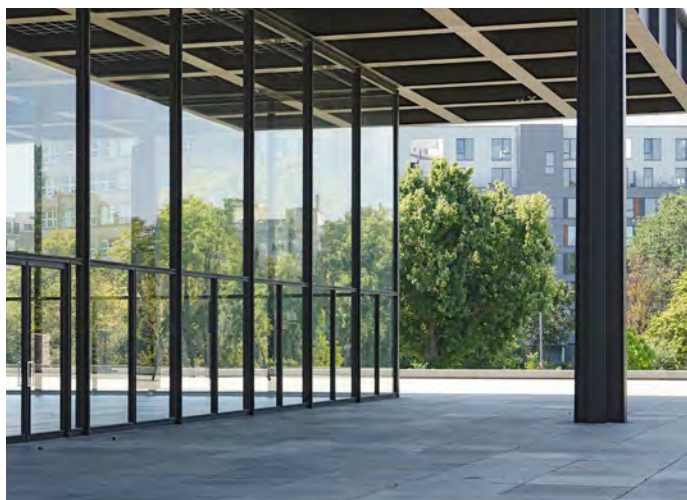
Trasparenza e apertura come ideale di modernismo caratterizzano l'architettura della Nuova Galleria Nazionale a Berlino. Per gli uccelli, la libera visuale attraverso l'edificio in vetro diventa una trappola mortale.
