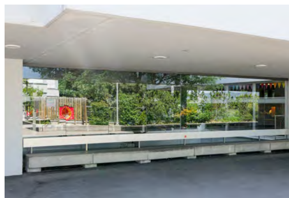
Sebbene l'edificio sporga per diversi metri, sulle finestre si possono vedere chiari riflessi che l'ombra non elimina.
