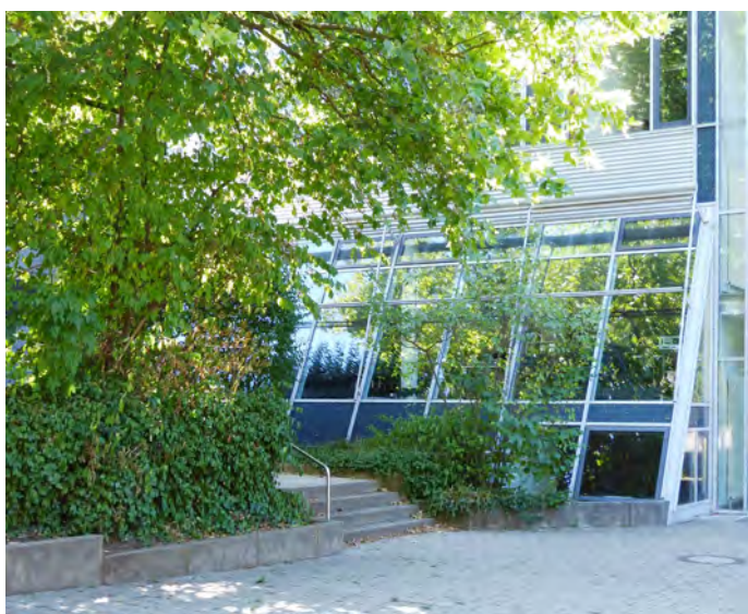
I riflessi su questa facciata inclinata in vetro di un edificio scolastico sono nitidi come su un vetro verticale e quindi comportano un alto rischio di collisione.
