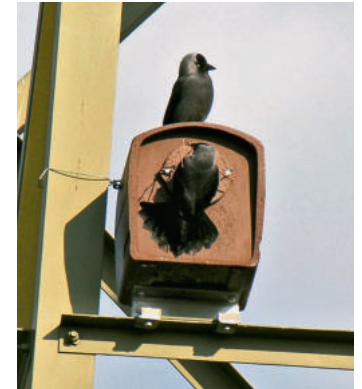
Ce nichoir de Schwegler a déjà bien fait ses preuves sur les pylônes électriques. Un élément supplémentaire est toutefois nécessaire pour le fixer (photo : Stephan Strebel).
