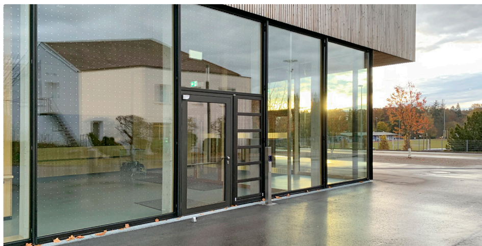
Afin d'éviter les collisions des oiseaux avec le verre, les grandes vitres du centre sportif de Waldau à Stuttgart ont été équipées d'un marquage protégeant les oiseaux (© Rouven Seidler).
